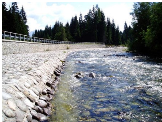
Obr. 37 Dnový stabilizačný prah v Liptovskom Hrádku (vľavo) a betónovo-kamenná opora cestnej komunikácie medzi Pribylinou a Podbanským (vpravo) (Foto: KIDOVÁ 2009).
