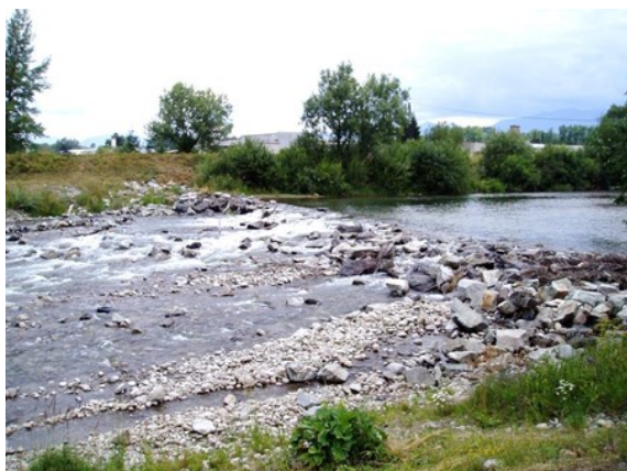
Obr. 37 Dnový stabilizačný prah v Liptovskom Hrádku (vľavo) a betónovo-kamenná opora cestnej komunikácie medzi Pribylinou a Podbanským (vpravo) (Foto: KIDOVÁ 2009).
