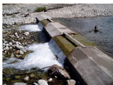
Obr. 38 Prevádzka MVE nad diaľničným mostom za Dovalovom kopíruje ľavostrannú polohu koryta v rokoch 1949 – 1961 (vľavo a v strede). Vybudovanie bezpečnostného prepadu v súčasnom aktívnom koryte (vpravo) obmedzuje jeho laterálnu migráciu.
