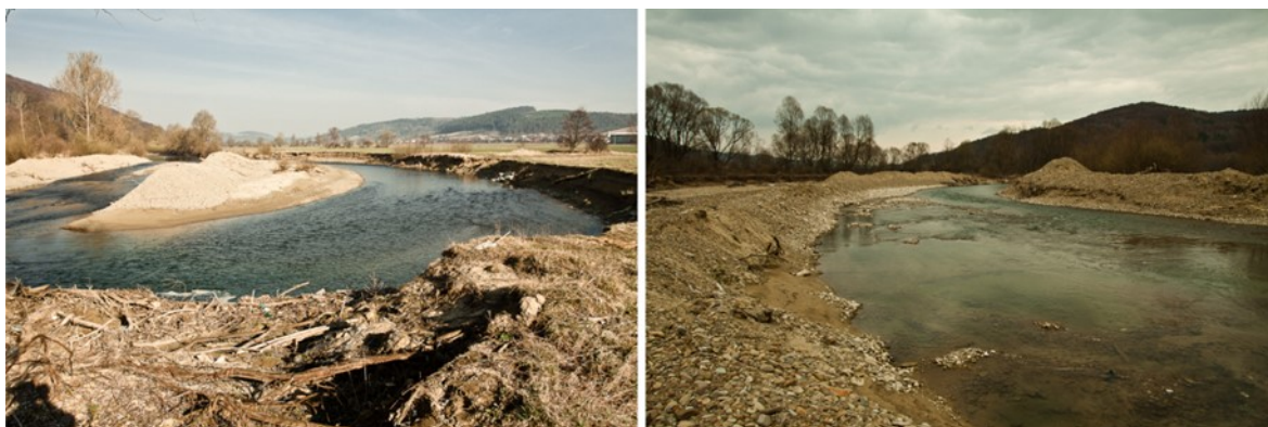
Obr. 38 Úprava koryta prebagrovaním štrkových lavíc po brehovej erózii po povodniach neďaleko obce Lascov (ľavý obrázok) a nad obcou Hrabovec (pravý obrázok). (Farebný obrázok dostupný online).
