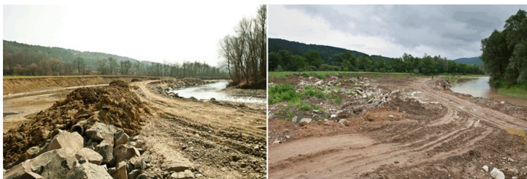
Obr. 37 Príklad nesprávneho manažmentu vodného toku. Vodný tok po brehovej erózii bol navrátený do pôvodnej polohy výstavbou hrádze spevnenej lomovým kameňom (ľavý obrázok). Priestor medzi hrádzou a bývalým erodovaným brehom bol vyplnený stavebným odpadom (pravý obrázok). V súčasnosti pokračuje erózia hrádze. (Farebný obrázok dostupný online).
